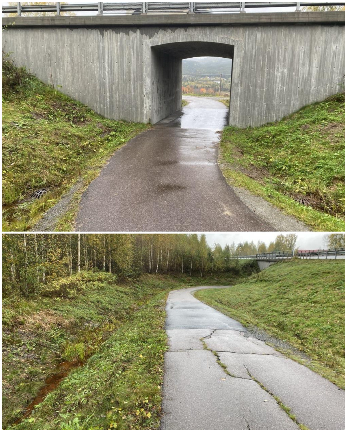
Figur 7: Mulig område for tiltak med ledegjerde ved Skøyen. Liten bekk langs gangveien ned til undergangen. (Foto: Elida Sandneseng, 2024).
