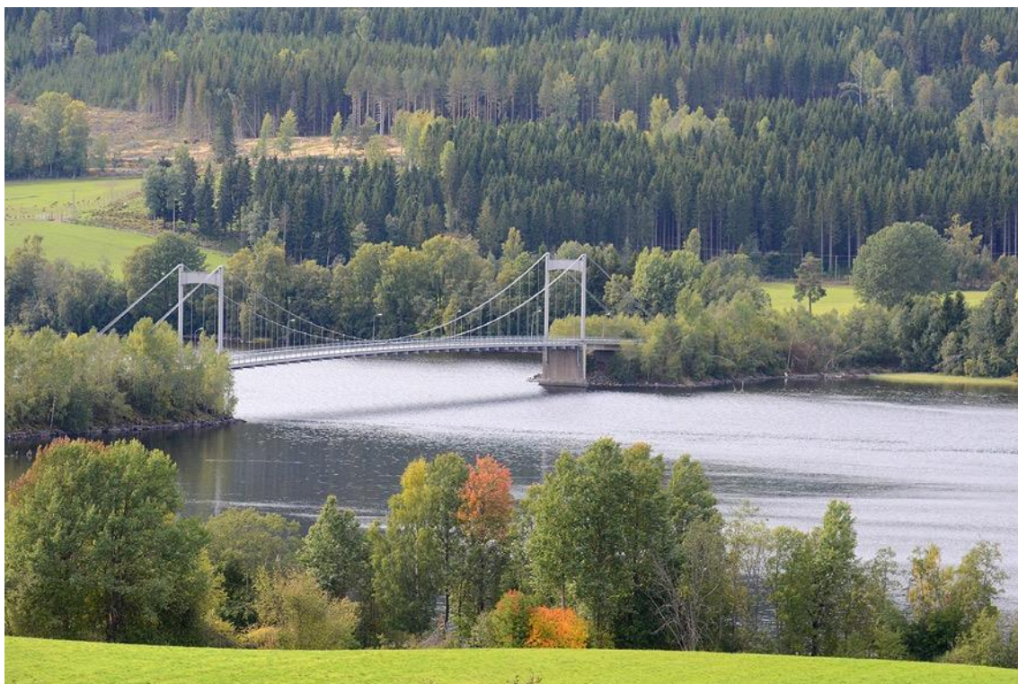
Fig. 9. Fluberg bru over Randsfjorden.
