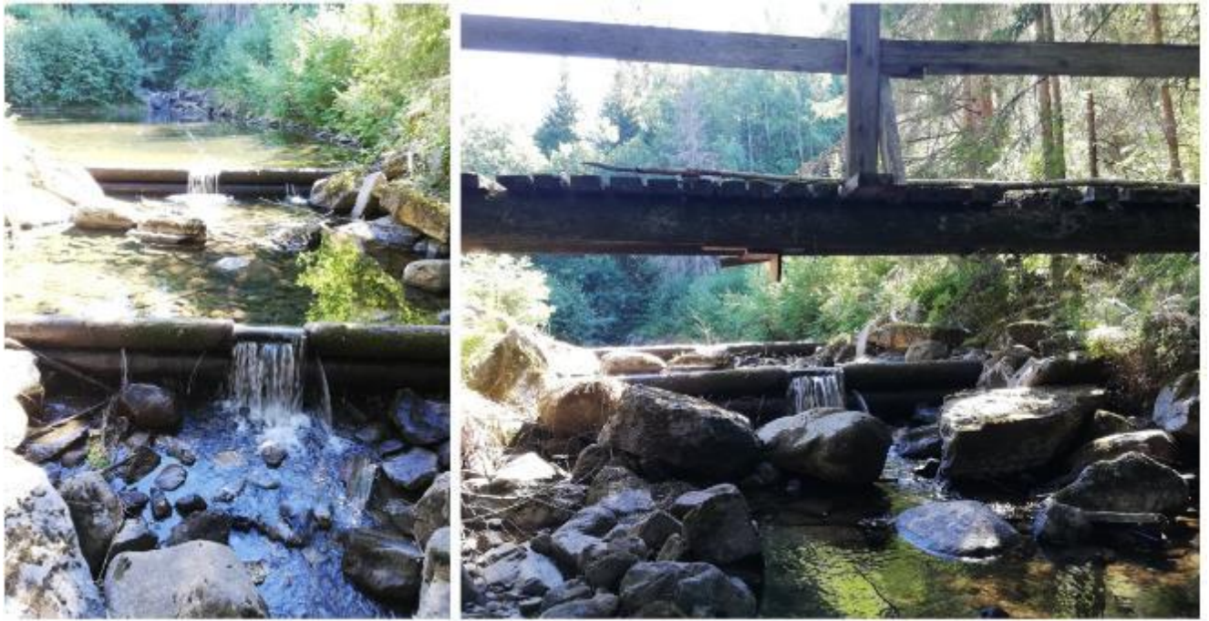
Figur 6. Oppstrøms i Svenåa er det demt opp et basseng (strekning C). Her var elva preget av begroing og lav vannføring. To trappetrinn laget av tømmerstokker stuer opp vann og sediment, og utgjør to menneskeskapte terskler. Det er usikker om fisken klarer å komme seg videre oppover i Svenåa. (Foto: A. Rishatt, 2022).
