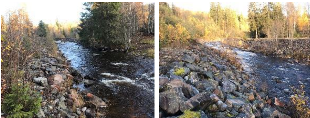
Figur 26. Landåselva (strekning B). Kanalisering, senkning og flomsikring av elvebredden preger strekningen. Vannhastigheten er høy, og noen større steiner er de eneste elementene som skaper variasjon i strømningsmønsteret. Elvebredden består av grove stein, delvis sprengstein (t.h.) og kantsonen er stedvis ikke til stedet. (Foto: L. Hoch, 2022).
